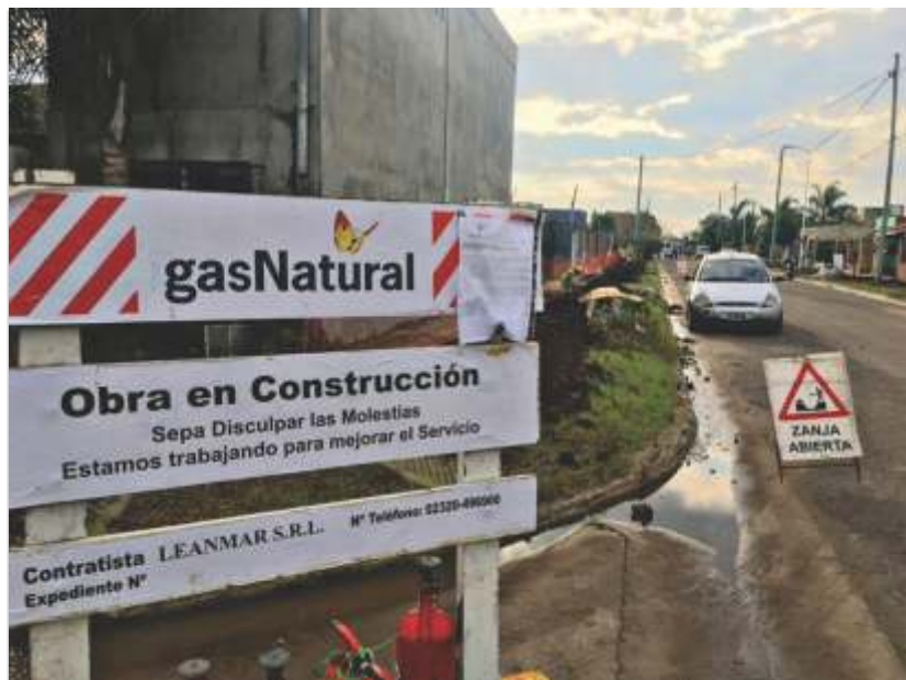
AVANZA OBRA DE GAS NATURAL EN GESTIÓN DE ISHII EN JOSÉ C. PAZ
