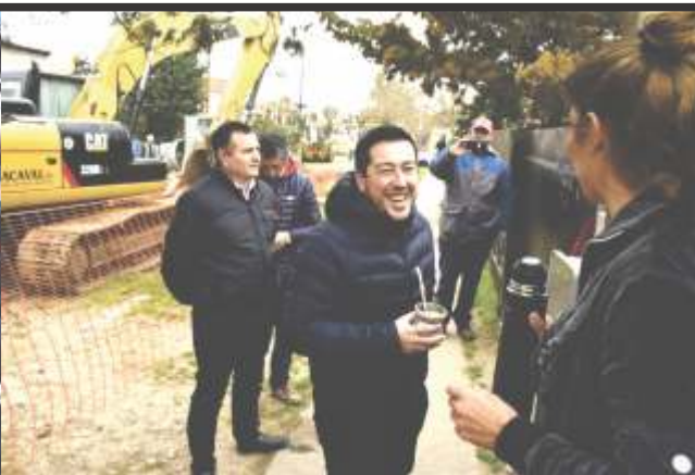
100 MILLONES DE PESOS EN MEGA OBRAS HIDRÁULICAS EN MALVINAS ARGENTINAS
