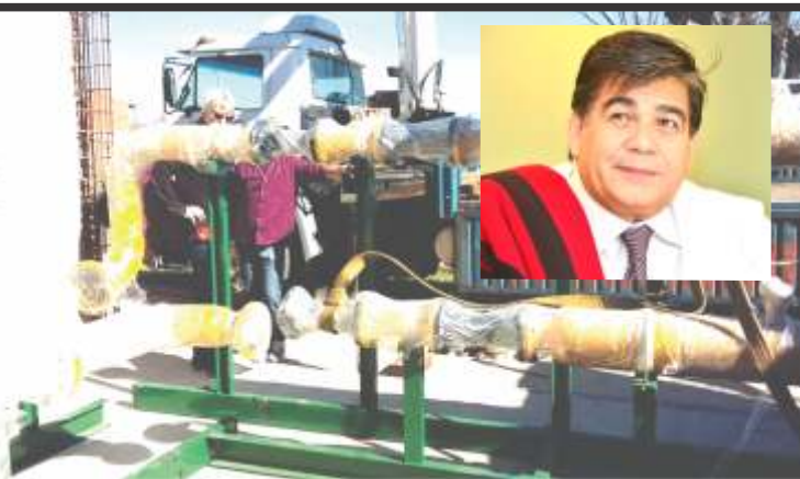
OBRA DE GAS NATURAL PARA JOSÉ C. PAZ IMPULSADA EN LA GESTIÓN DEL INTENDENTE ISHII
