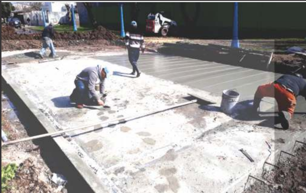
ASFALTO E HIDRÁULICA EN BARRIO IDEAL DE JOSÉ C. PAZ. “JUNTOS POR EL BUEN CAMINO”
