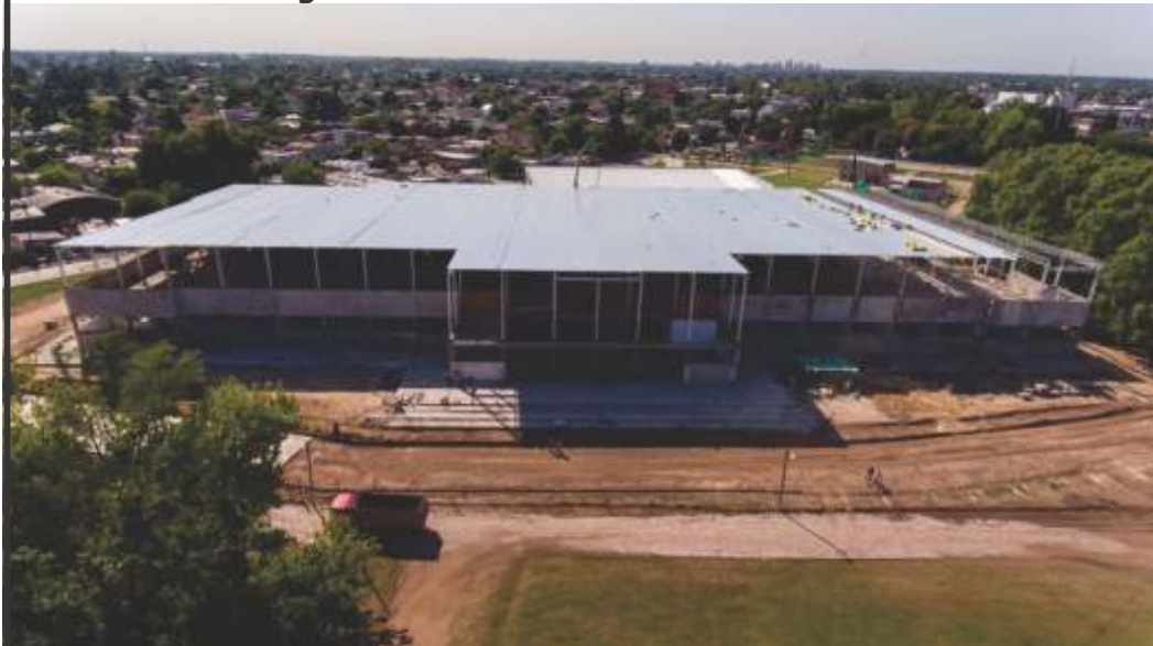
NOTABLE CRECIMIENTO DE LA OBRA DEL EDIFICIO PARA LA FACULTAD DE MEDICINA DE JOSÉ C. PAZ.
